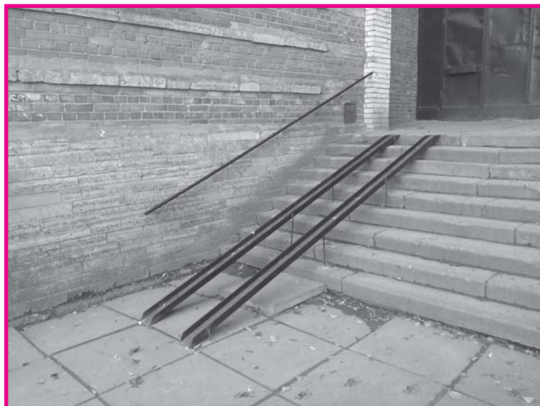
Ул. Сантьяго-де-Куба, д.4. Поручень расположен далеко от направляющих. Подъем по этим швеллерам для инвалида-колясочника затруднен.
