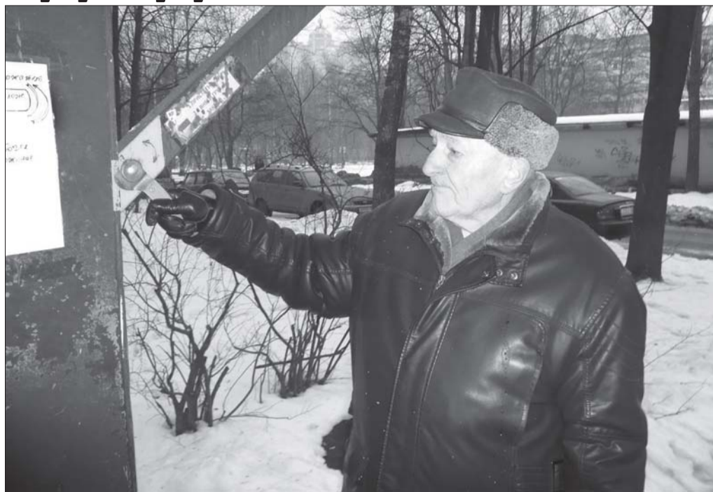
С помощью нехитрого приспособления – эксцентрика и рычага открытая дверь легко фиксируется и проход (проезд) в подъезд свободен.
